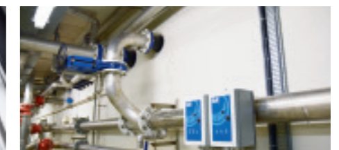
Efter fermentering transporteres slammet til en buffertank før endelig afvanding.
