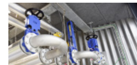
I rådnetanken recirkuleres slammet gennem en varmeveksler.
