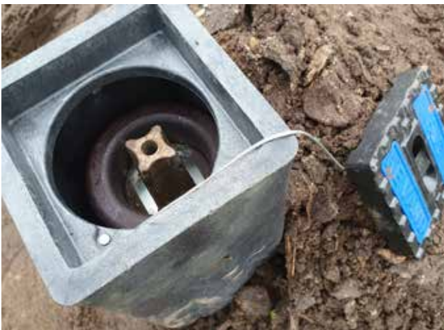
VIDI Positioner installeret i et plastgadedæksel
