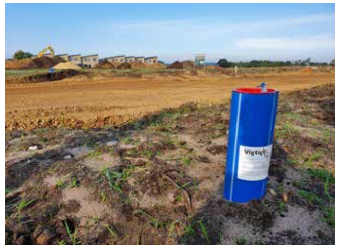
Midlertidigt indløb til ny byggeplads med sensorer installeret
